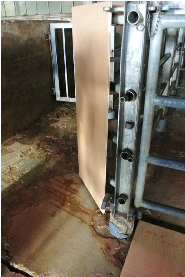
Pannello laterale in situ
